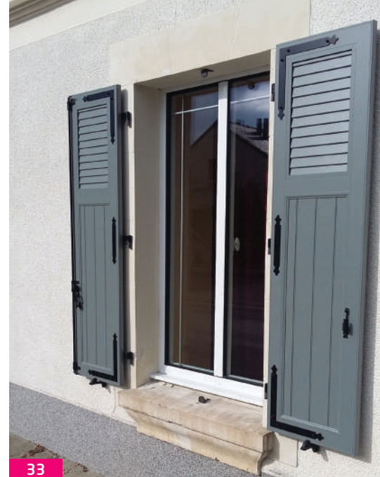
Pentures coudées (pour 2 vantaux du même côté)
