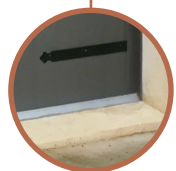
Seuil galva (en option pour les portes PVC)
