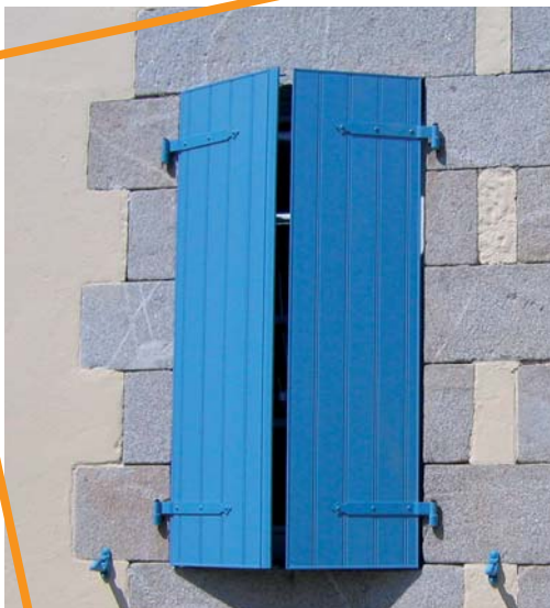
Vue extérieure - Volets fermés
