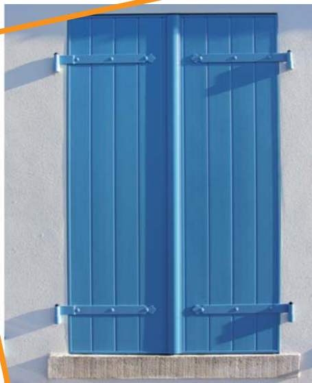
Vue extérieure - Volets fermés
