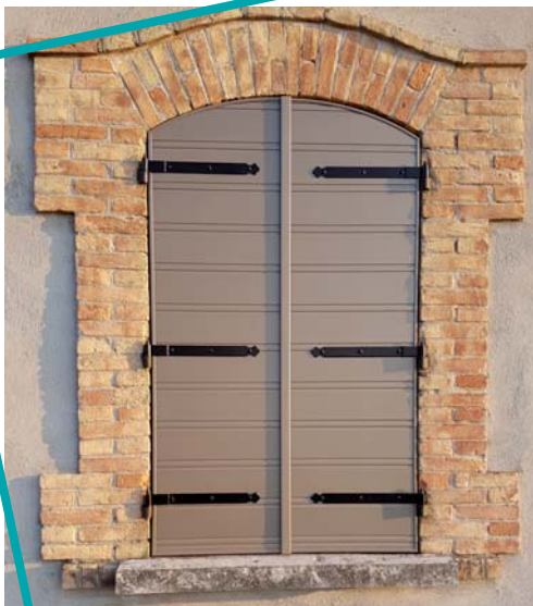
Vue extérieure - Volets fermés
